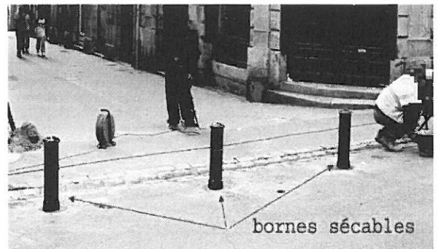
Bornes sécables par un homme sur poussée
